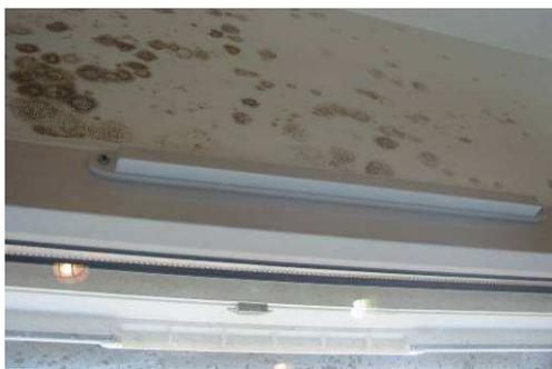
**Figure 17 : Ventilation insuffisante (bât 16 internat colonne hébergement)**
