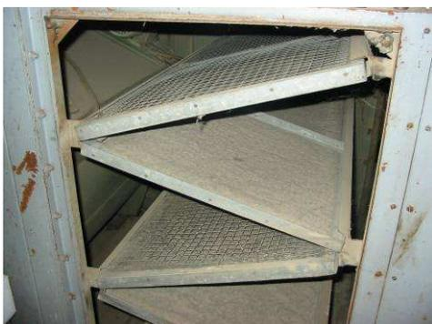
**Figure 11 : Filtres CTA Gymnase non remplacés**
