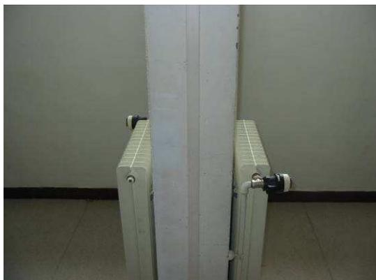
**Figure 7 : Radiateurs avec robinets thermostatiques (bât 16)**
